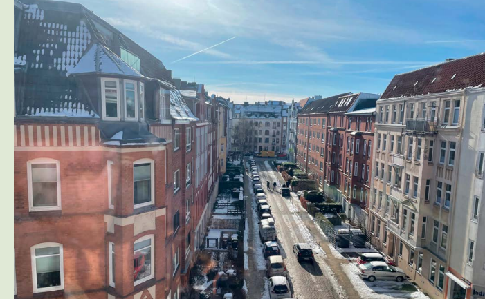
Gute Lage: Möglicher Wohnraum durch Aufstockung/Dachausbau in der Von-der-Horst-Straße. Foto: U. Hunold
